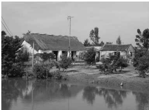
Hình 5. Hình ảnh nhà ở ven biển Bắc Bộ đã thay thế tường gạch và một phần mái lợp ngói thay cho mái lợp bổi [6]
