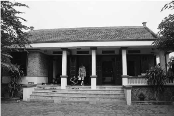
Hình 9. Hình thức kiến trúc ngôi nhà vùng Đồng bằng Bắc Bộ kết hợp mái hiên Tây, cột xây gạch và sử dụng gian lồi che một phần hiên trước nhà [6]
