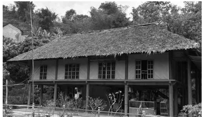
Hình 8. Kiến trúc ngôi nhà sàn vùng miền núi phía Bắc đã kết hợp hài hòa giữa vật liệu hiện đại bê tông cốt thép với vật liệu bản địa để lưu giữ lại giá trị kiến trúc truyền thống
