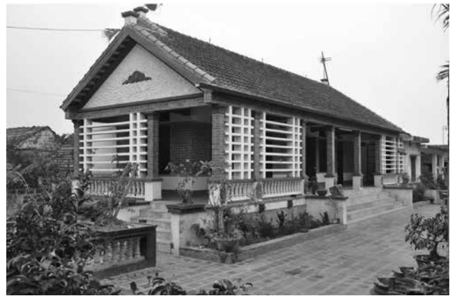
Hình 6. Ngôi nhà Đồng bằng Bắc Bộ xây dựng theo xu hướng tiếp biến kiến trúc nhà ở truyền thống (vật liệu tường gạch xây, vì kèo gỗ gác lên tường chịu lực, mái lợp ngói) [6]
