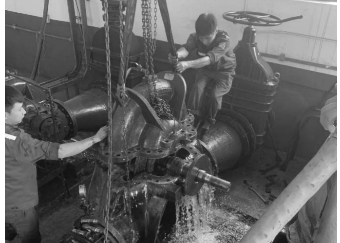
Hình 3. Tuyến điện 35KV bị hư hỏng do cơn bão số 3/2024, khiến việc vận hành Nhà máy nước Diễn Vọng bị ngưng trệ.
