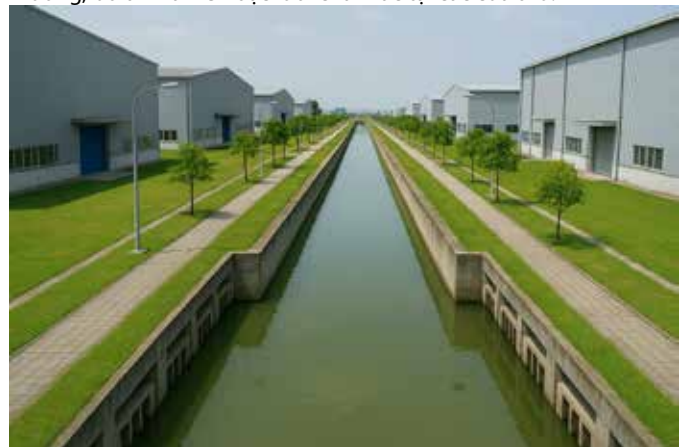
Hình 4. Xây dựng kênh thoát nước mưa, tạo cảnh quan trong KCN [10]
