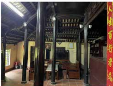
Hình 5. Cột nhà rường: Chân gỗ, cột gỗ, đầu cột
