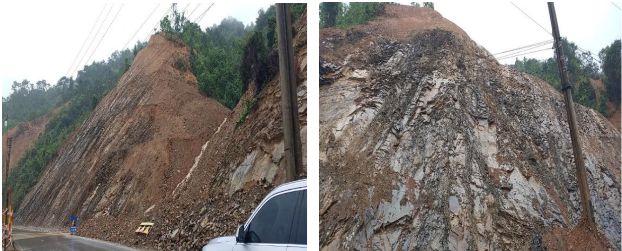
Hình 1. Hình ảnh hiện trạng trượt mái dốc đá
